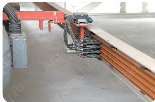
Пример установки токосъёмника
